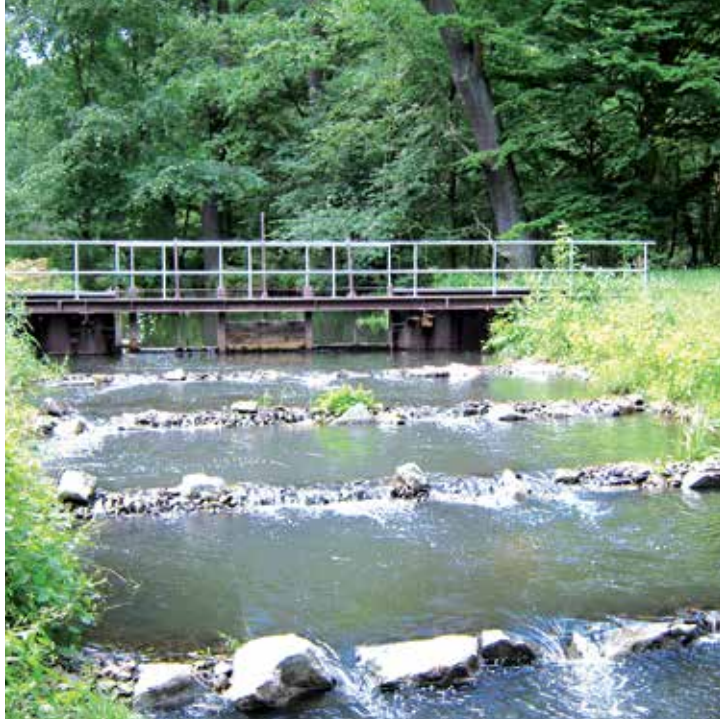
Fischaufstieg am Wehr Lehmannstrom, Tuschatzwiesen (Abb. rechts)
